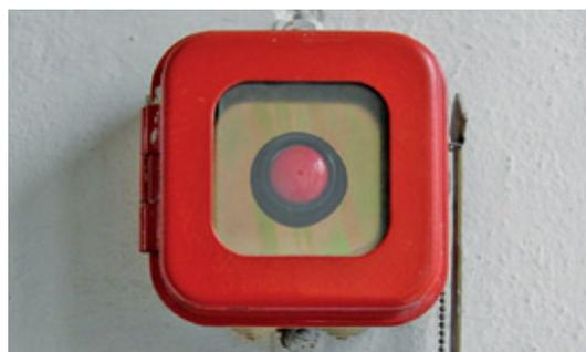
Figura 1.8: Pulsante di sgancio per apertura DG cabina
