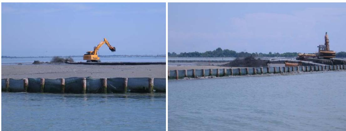
**Figura 2.14** - Esempi di refluentamento per ripristino morfologico in ambienti di transizione, con conterminazioni provvisorie costituite da sistemi di pali e reti filtranti (fonte ISPRA)
