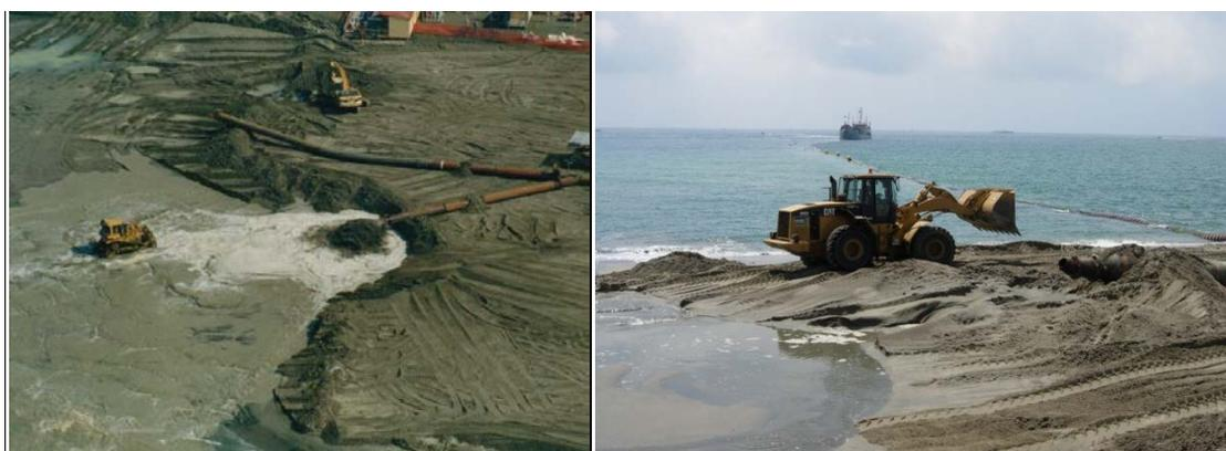
**Figura 2.13** - Esempio di redistribuzione e regolarizzazione del sedimento sversato mediante mezzi meccanici (fonte ISPRA).
