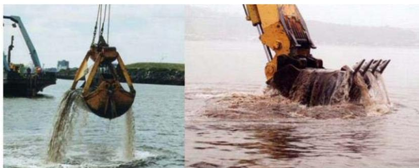
**Figura 2.4** – Rilascio (*spillage*) durante la risalita di una draga a grappo (a sinistra) e a cucchiaio (a destra).
