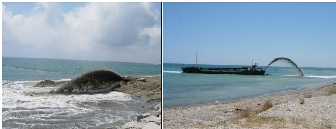
**Figura 2.12** - Esempio di sistemi di sversamento con pompe centrifughe e condotte sommerse o galleggianti (a sinistra, fonte ISPRA) e di sistemi di sversamento del tipo rainbowing (a destra, fonte ISPRA).
