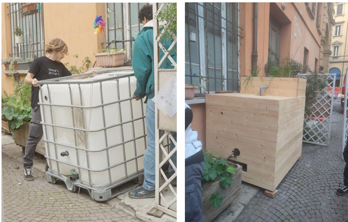
FIGURA 28, 29. L'INSTALLAZIONE DELLA CISTERNA.
