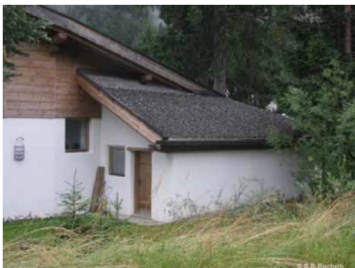
Figura 14: esempio di tetto in ghiaia (Tirolo, Austria; foto Bischetti)
