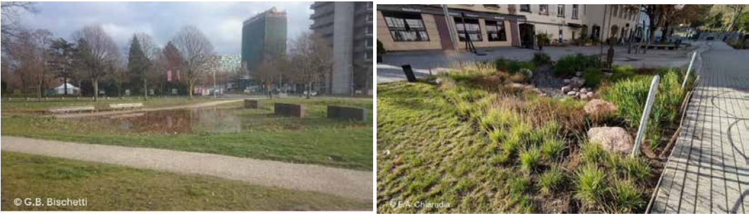
Figura 18: piccolissima depressione con finalità di area di infiltrazione (a sinistra: Utrecht, Olanda; foto Bischetti; a destra Vilnius, Lituania; foto Chiaradia))
