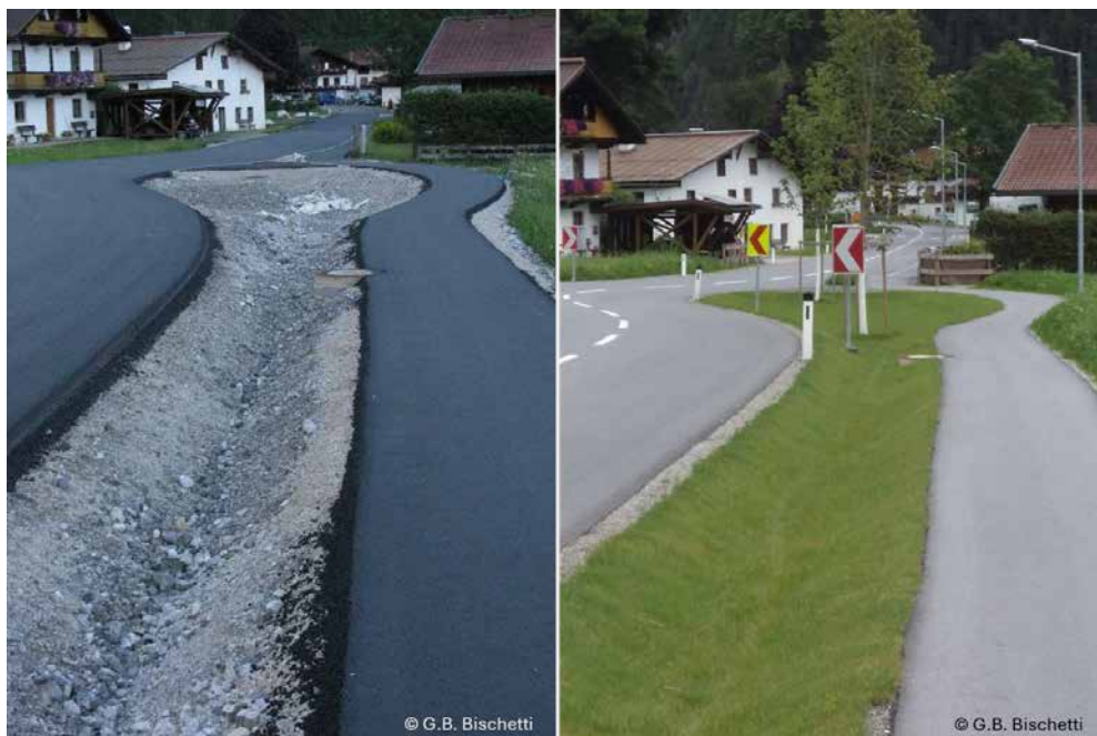
Figura 17: avvallamento nella fase costruttiva e un anno dopo (Tirolo, Austria; foto Bischetti)
