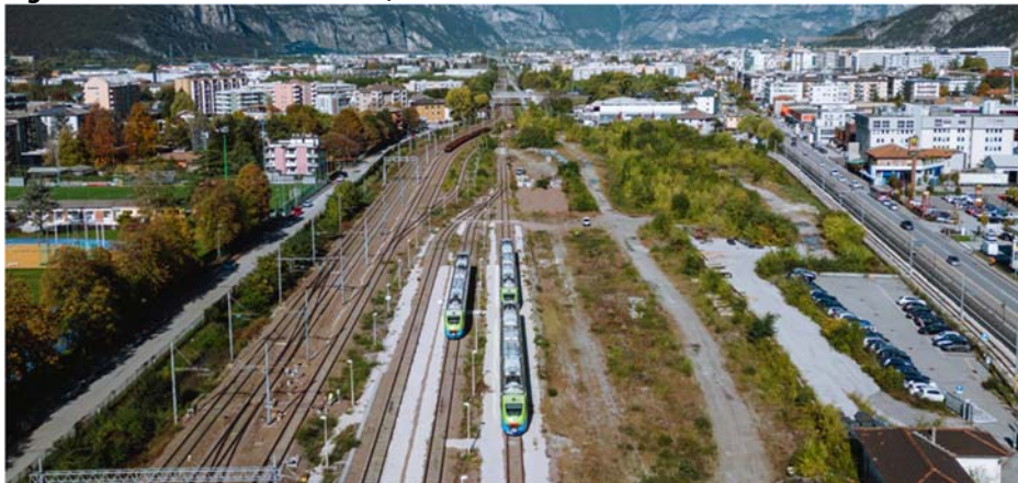
Figura 78 - Ferrovia del Brennero, nel tratto che va dallo Scalo Filzi al Muse
