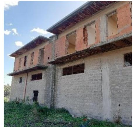
Figura 15 - Edificio A con forati di laterizio
