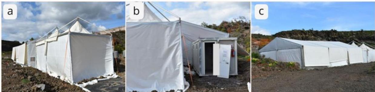
Figure 10 a, b, c - Confinamento in tendostruttura in depressione con UDP per la demolizione di edifici
