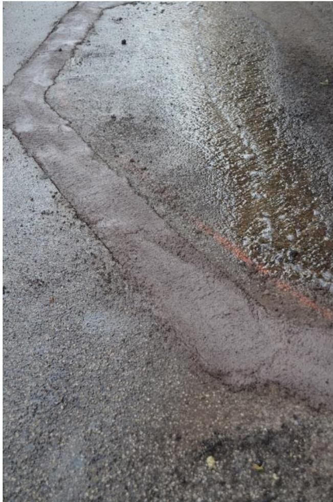
**8. “Cicatrice” da scavo su sede stradale. “Mini-trincea” riempita di malta cementizia realizzata per la posa di cavi in fibra ottica in una strada dell’abitato di Biancavilla.**
