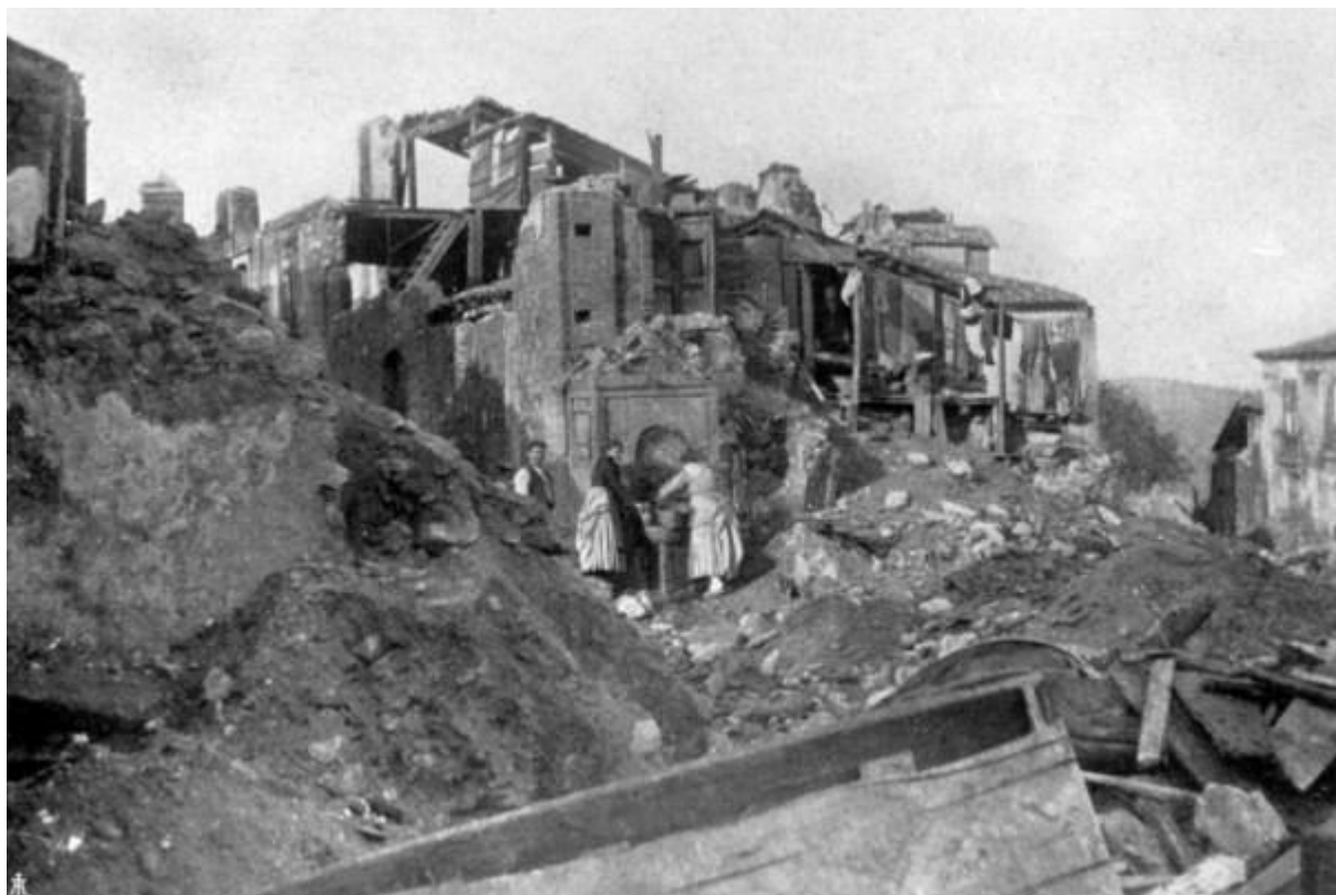
Sant'Eufemia d'Aspromonte (RC): abitazioni distrutte.
