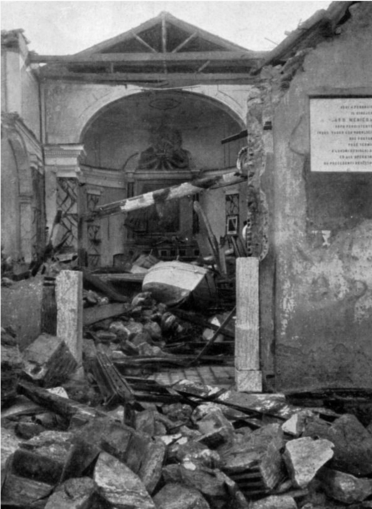
Pellaro (RC): una barca trascinata dal maremoto all'interno della chiesa della Madonnella, crollata a causa del terremoto. Poco a sud di questo paese lo tsunami raggiunse l'altezza massima rilevata di circa 13 metri.
