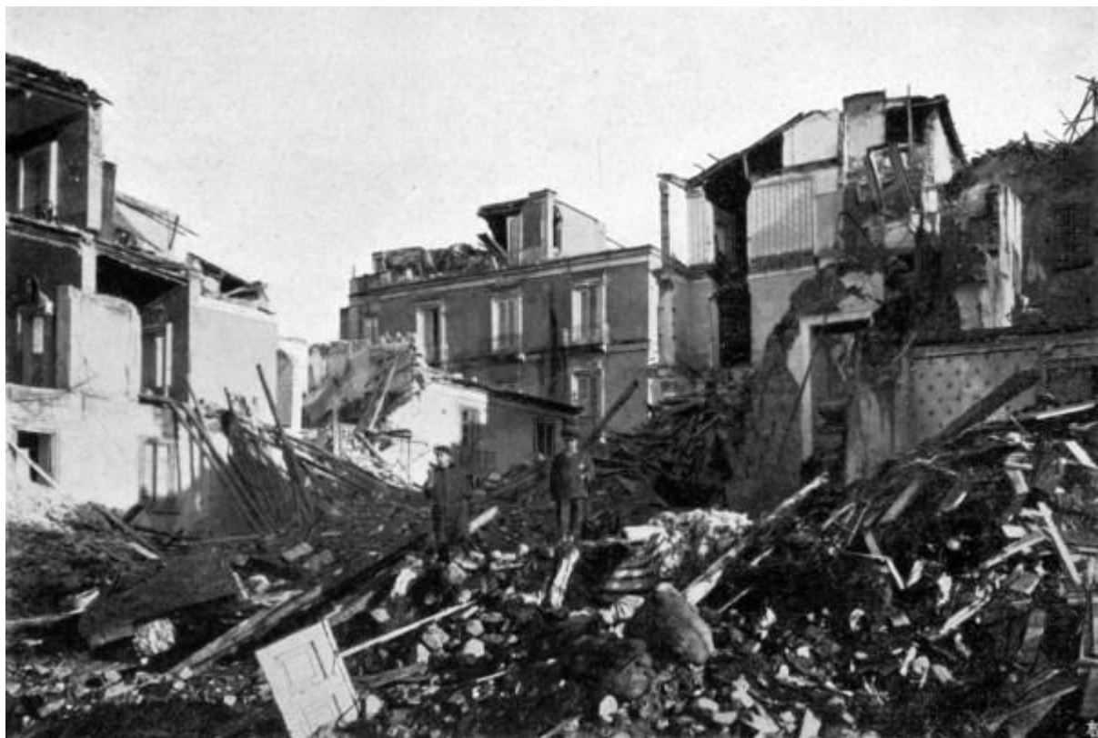
Reggio Calabria: crolli in corso Garibaldi.
