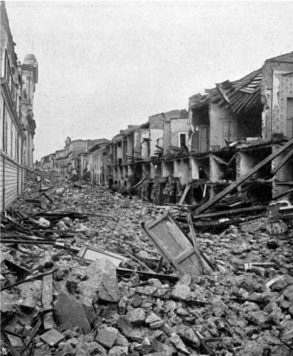
Messina: edifici distrutti in via Cardines.
