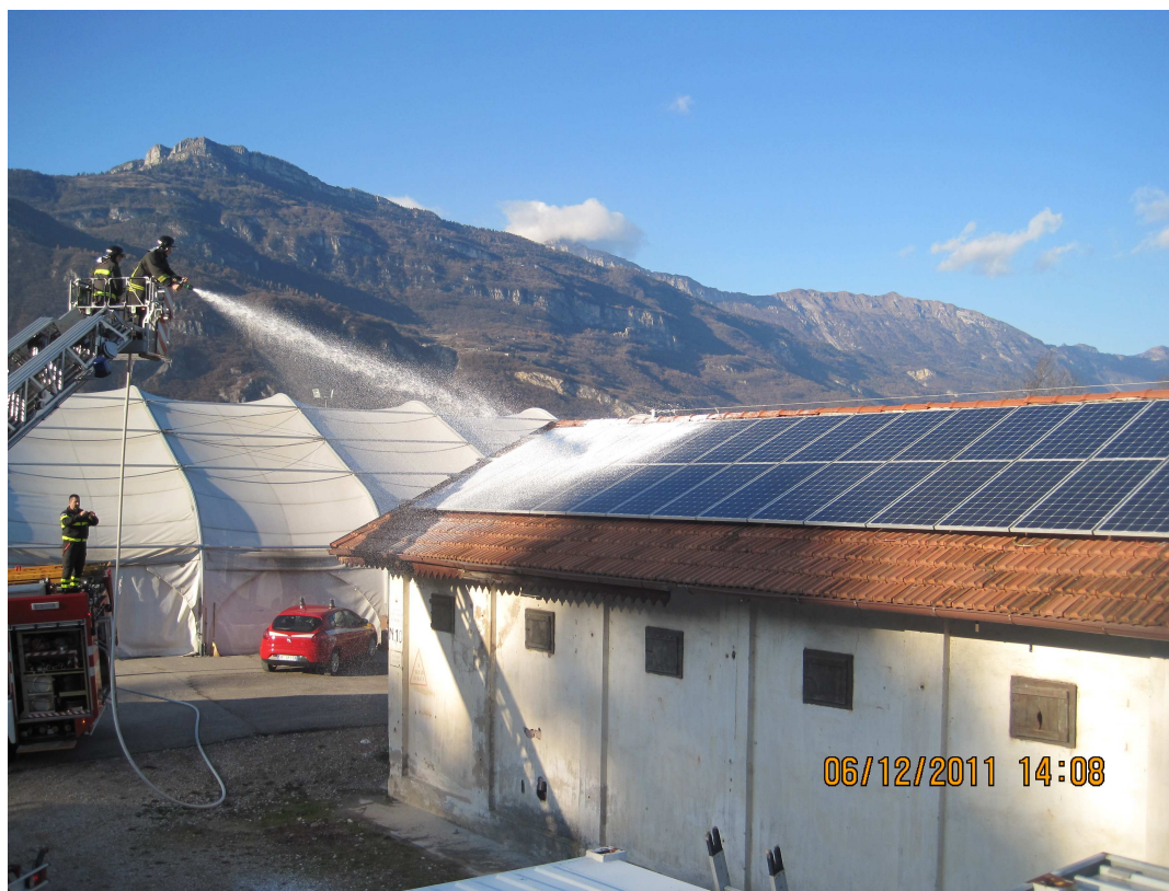
Figura 5-5: prova con CAFS: fase di schiumaggio
