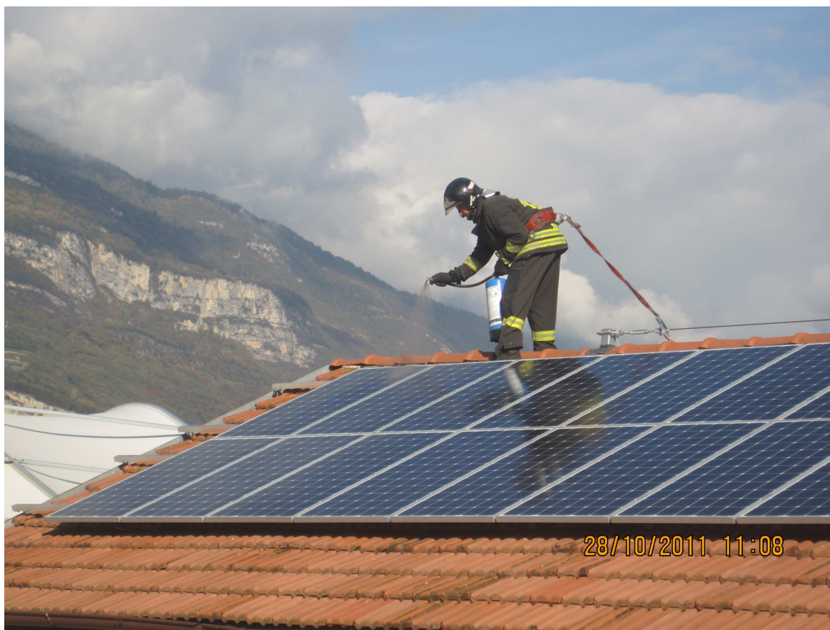
Figura 5-14: prova con PreventoSolar: inizio primo spruzzata
