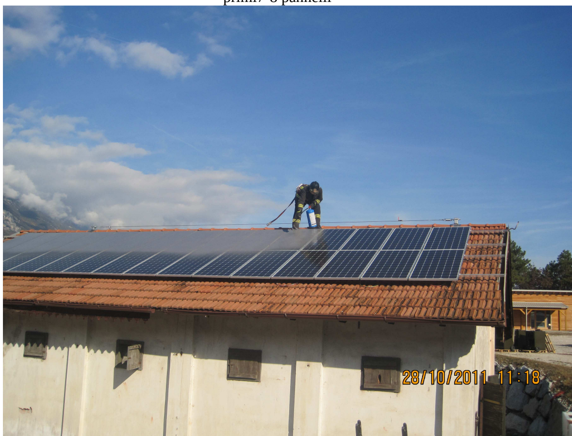
Figura 5-17: prova con PreventoSolar: fine seconda spruzzata, copertura dei primi 10-11 pannelli
