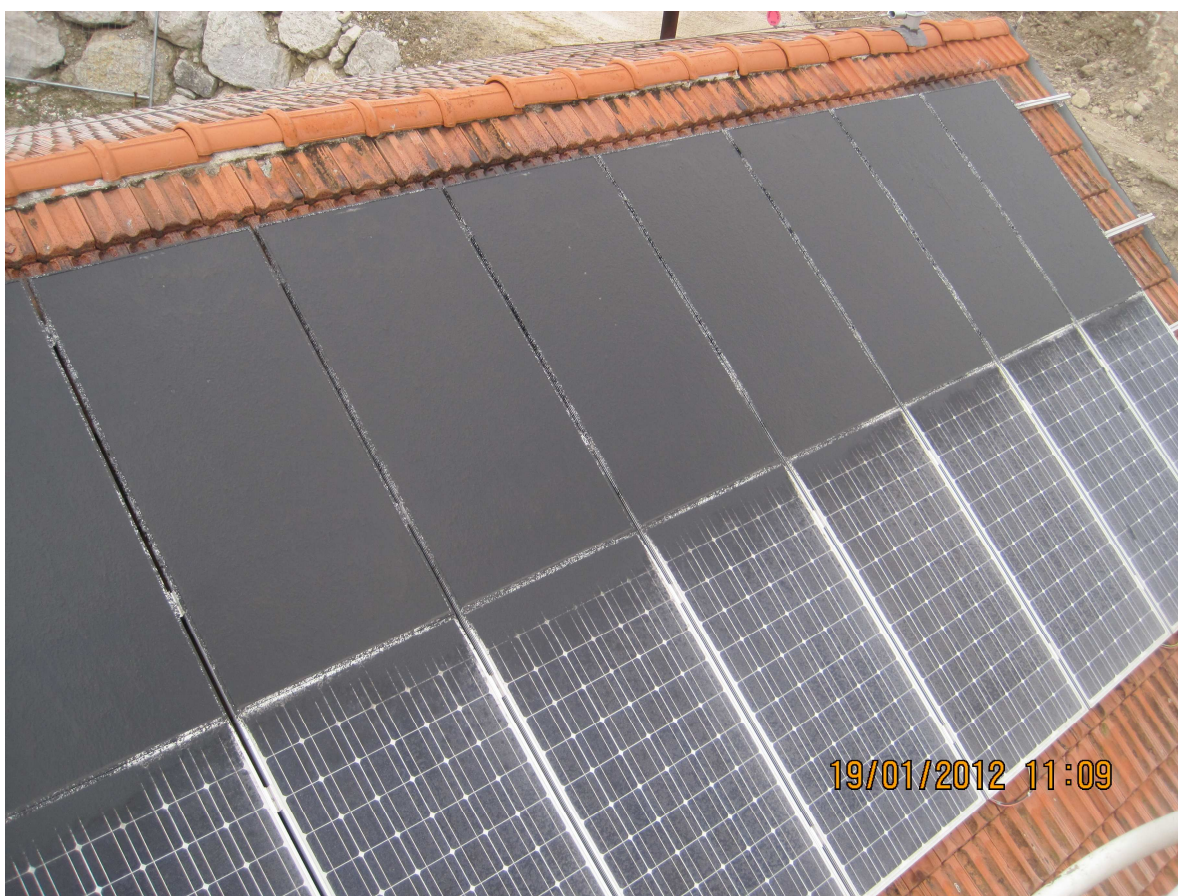
Figura 5-24: prova con Prevento Solar: copertura finale dei pannelli
