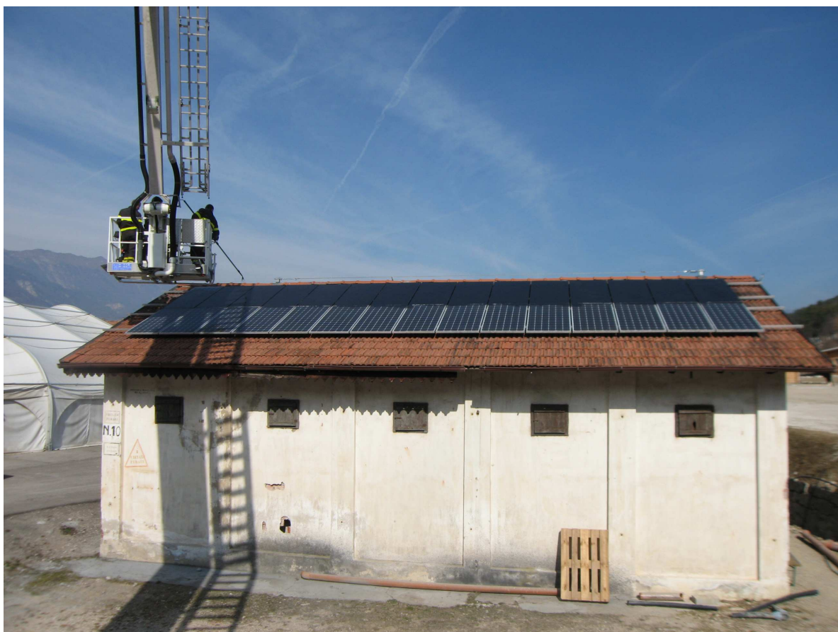
Figura 5-32: prova con gel Prevento Solar: copertura di tutti i pannelli
