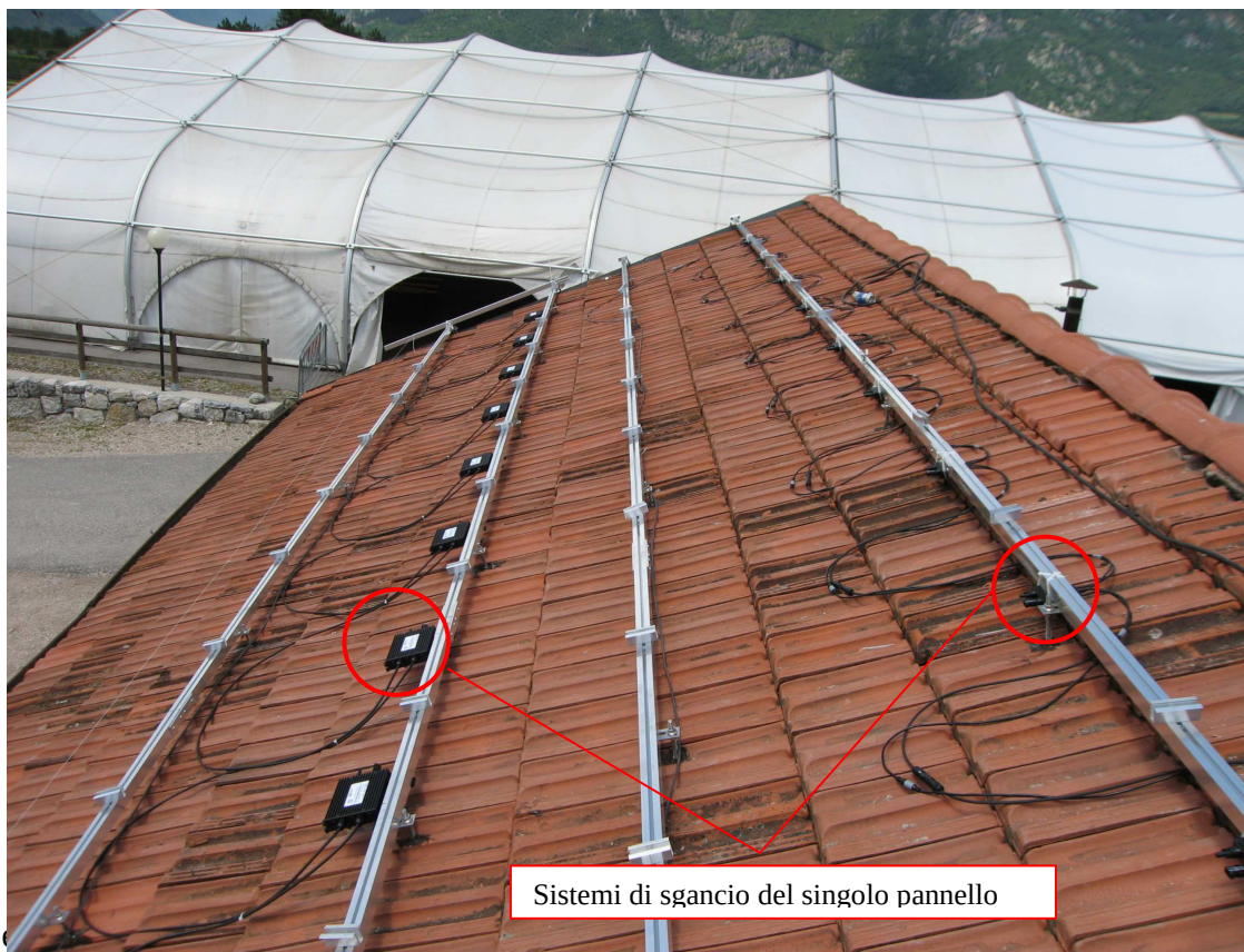
Figura 4-2: Particolare dell'impianto che mostra le due tipologie di sgancio dei pannelli fotovoltaici
