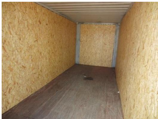
Figura 7.53 Revestimiento de un contenedor de 40 pies con paneles de cartón usado
