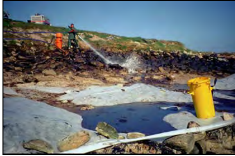
Figura 1.17 - Tecnica di lavaggio
