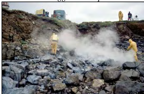
Figura 1.33 - Tecnica di lavaggio con acqua calda ad alta pressione
