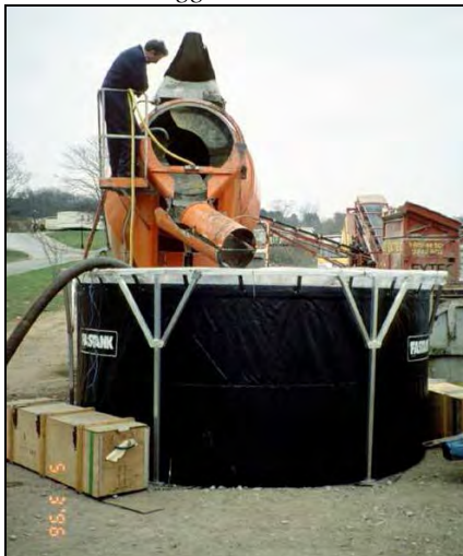
Figura 1.31 - Lavaggio con betoniera a tamburo
