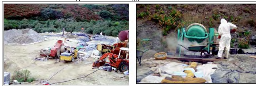
Figura 1.30 - Lavaggio con betoniera
