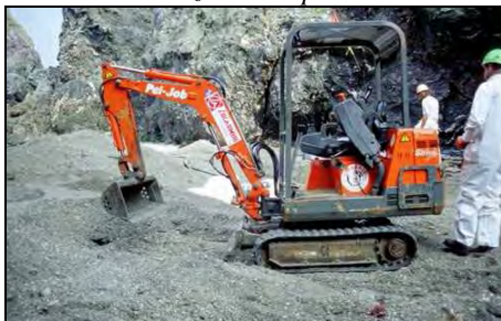
Figura 1.21 - Rimozione temporanea di sedimenti
