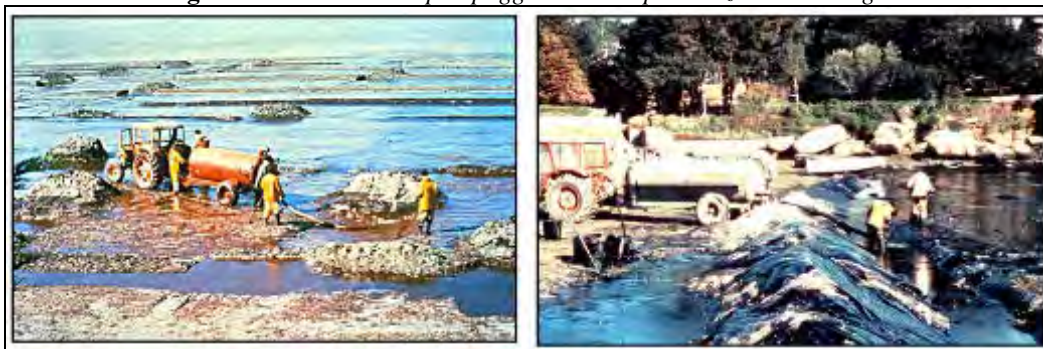
Figura 1.11 - Sistemi di pompaggio in corrispondenza della battigia
