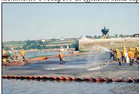
Figura 1.24 - Contenimento e recupero di effluenti sulla superficie dell'acqua
