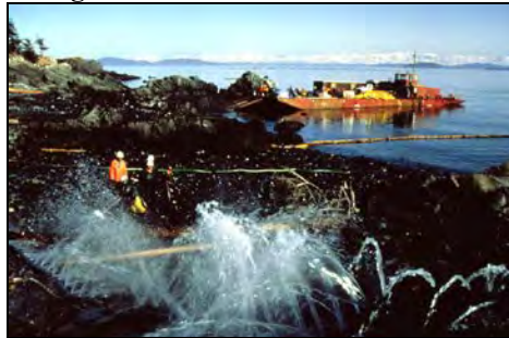
Figura 1.18 - Tecnica di inondazione
