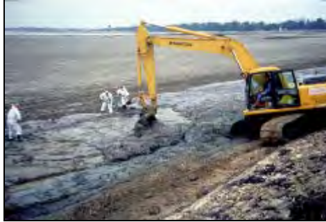
Figura 1.13 - Recupero mediante macchinari per movimento terra
