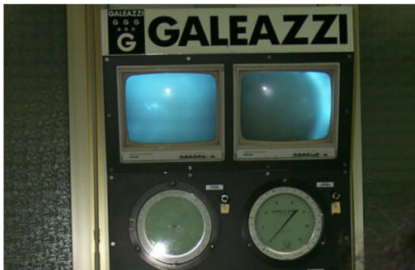
Figura 10 – Monitor video inseriti nel quadro di controllo della camera iperbarica verde, collegati a due video camere posizionate all'esterno in corrispondenza degli oblò della sezione di trattamento e di quella di trasferimento.
