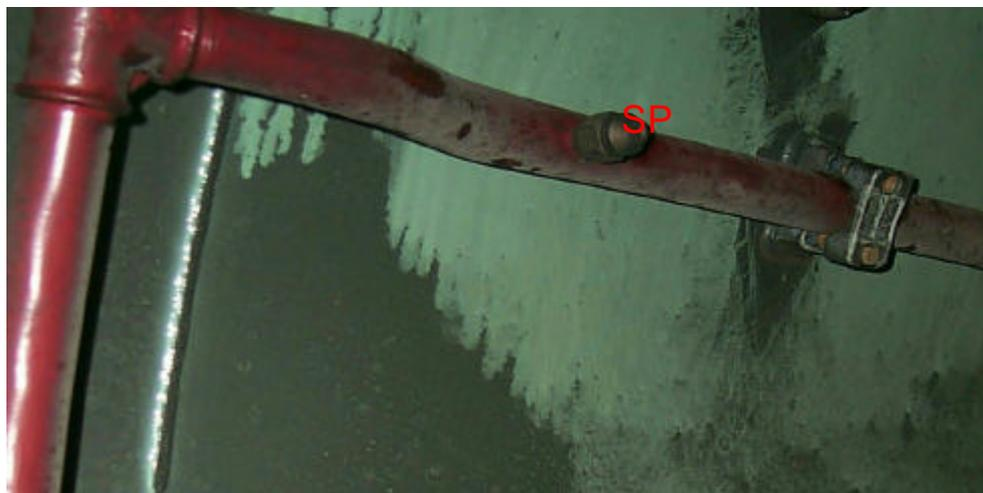
Figura 13 – Particolare di un lato dell'anello dell'impianto antincendio (rosso) ed uno sprinkler (SP), all'interno della camera iperbarica verde.
