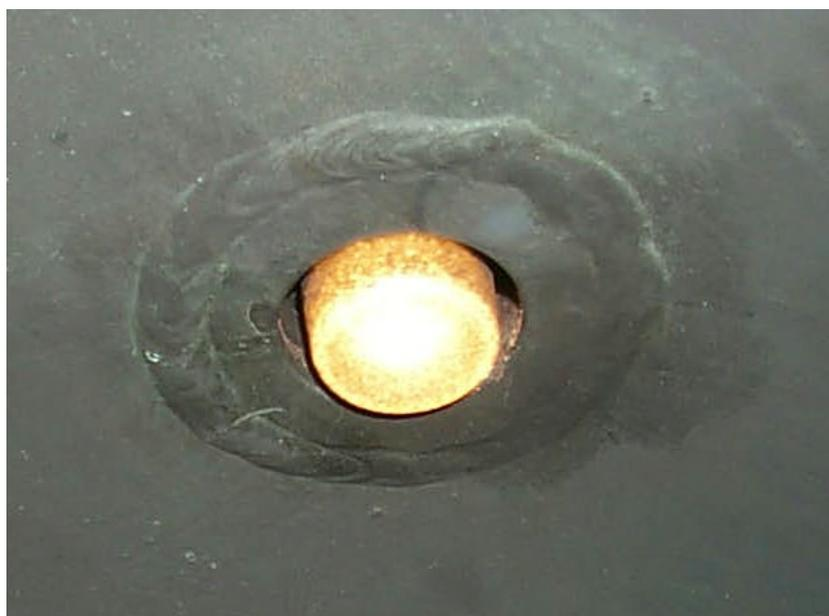
Figura 11 – Particolare di un elemento illuminante costituito da un cilindro in materiale plastico (verosimilmente metacrilato) passante attraverso allo scafo attraverso ad una apposita apertura. Si noti come la plastica sia alterata in superficie ma non presenti segni evidenti di esposizione prolungata ad alte temperature.
