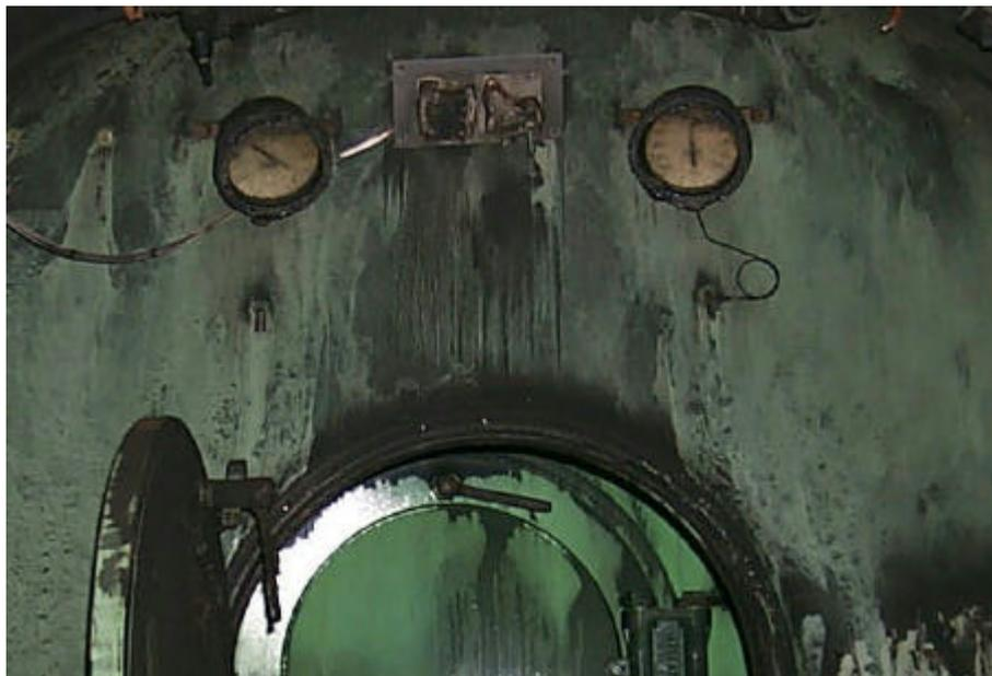
Figura 9 – misuratori di temperatura e di umidità relativa nella camera iperbarica verde dopo l'incidente.
