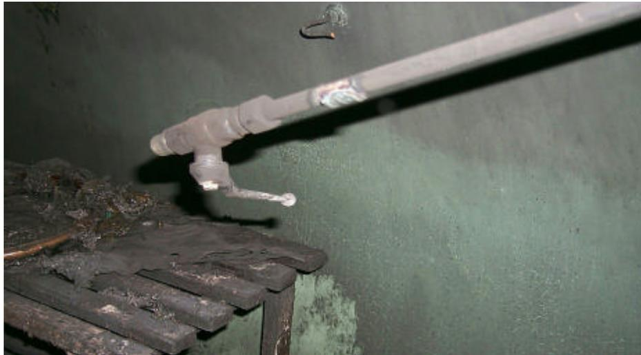
Figura 14 – particolare del tubo e della saracinesca di attivazione della doccetta, che però è evidentemente assente. La saracinesca, realizzata mediante una valvola a sfera da ½”, è nella posizione di chiusura.
