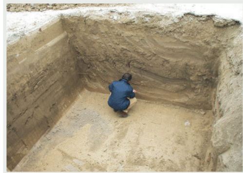
Fossa con possibile presenza di CO 2 , H 2 S, SO 2
