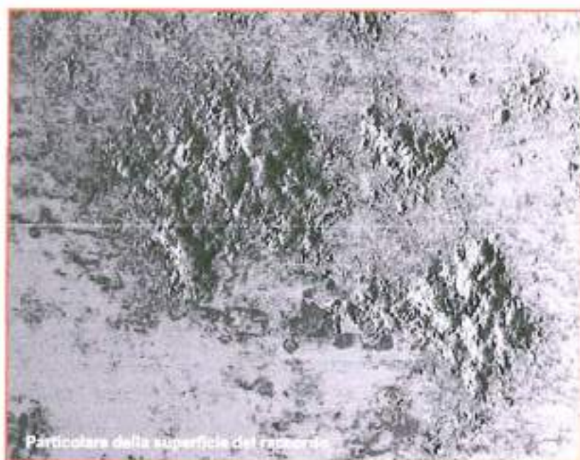
Figura 3.7-7 – Crateri di corrosione nella superficie di raccordo.
