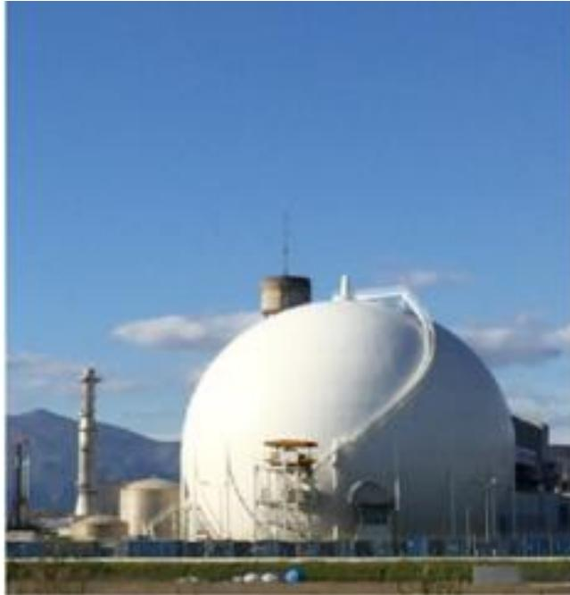
La centrale nucleare del Garigliano, sita in Sessa Aurunca (CE) e dotata di un reattore nucleare ad acqua bollente General Electric del tipo BWR da 506 MWt (150 MWe), entrò in esercizio commerciale nel giugno 1964, con una produzione elettrica complessiva, fino all'arresto definitivo, di circa 12 miliardi di kilowattora.
