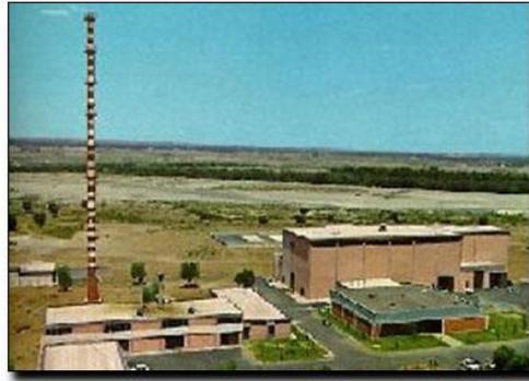
L'impianto ITREC, realizzato nel periodo 1965-1975, aveva come obiettivo la dimostrazione, su scala pilota, della fattibilità della chiusura del ciclo uranio-torio con il riprocessamento del combustibile esaurito e la rifabbricazione remotizzata del nuovo combustibile, utilizzando l'uranio (235U + 233U) e il torio recuperati.
