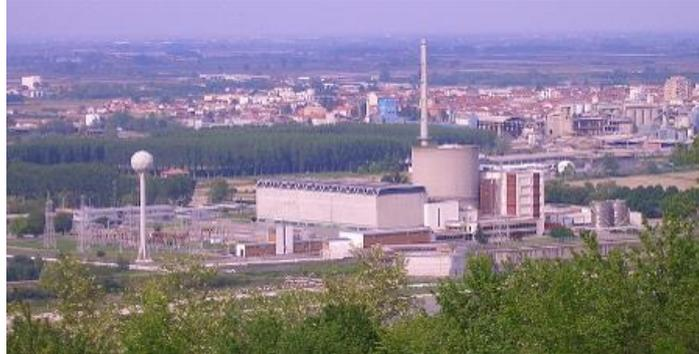
La centrale elettronucleare “Enrico Fermi” di Trino (VC), dotata di un reattore nucleare ad acqua pressurizzata Westinghouse del tipo PWR da 870 MWt (272 MWe), entrò in esercizio commerciale il 1/1/1965 e fu fermata il 21/3/1987, dopo aver prodotto complessivamente circa 25 miliardi di kilowattora. Con delibera CIPE del 26/7/1990 fu disposta la chiusura definitiva della centrale.
