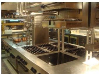
Sono locali destinati ad ospitare utilizzatori gas, generalmente alla pressione massima di 0,5 bar (e relativi impianti di alimentazione a gas), per la cottura dei cibi in alberghi, ristoranti, ospedali, mense aziendali ed ogni altro impiego simile ad esclusione dell'uso domestico.
