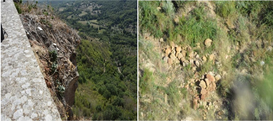
**Figura 3.2.3.4** - *Crollo recente nel versante SE della rupe di Civita sopra l'accesso al convento di San Bonaventura*
