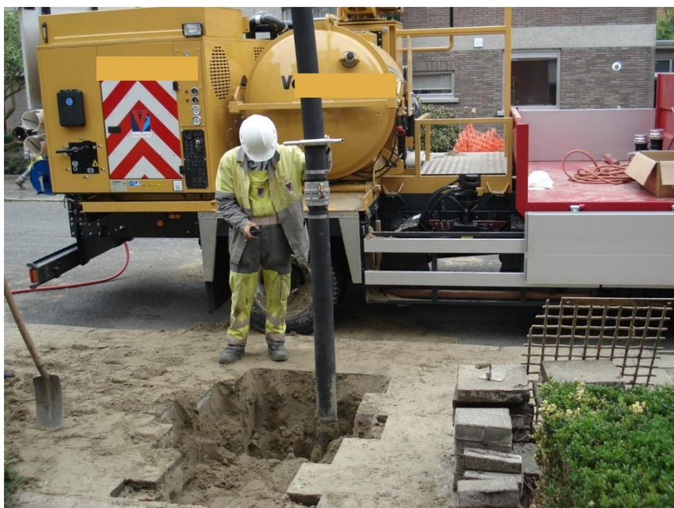
**Figura 3 - Esempio di impianto carrellabile basato su tecnologia di pompa del vuoto**
