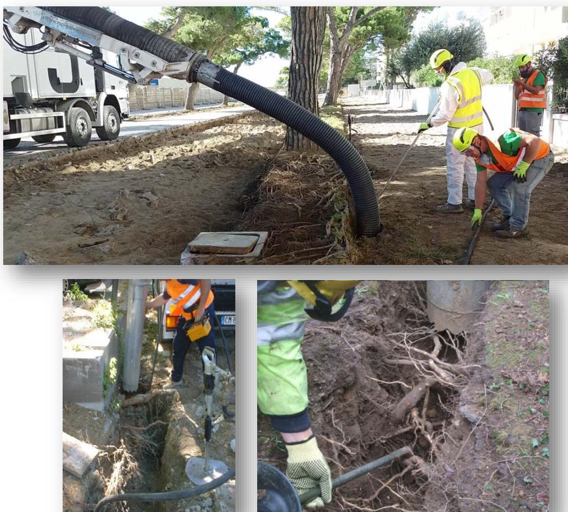
Figura 16, 17 e 18 - Aspirazione apparati radicali
